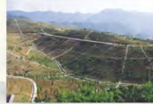
三峡库区坡改梯工程（重庆巫山）
